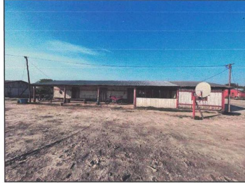
VISTA DE VIVIENDA DE PERSONALES EN CASCO 19
